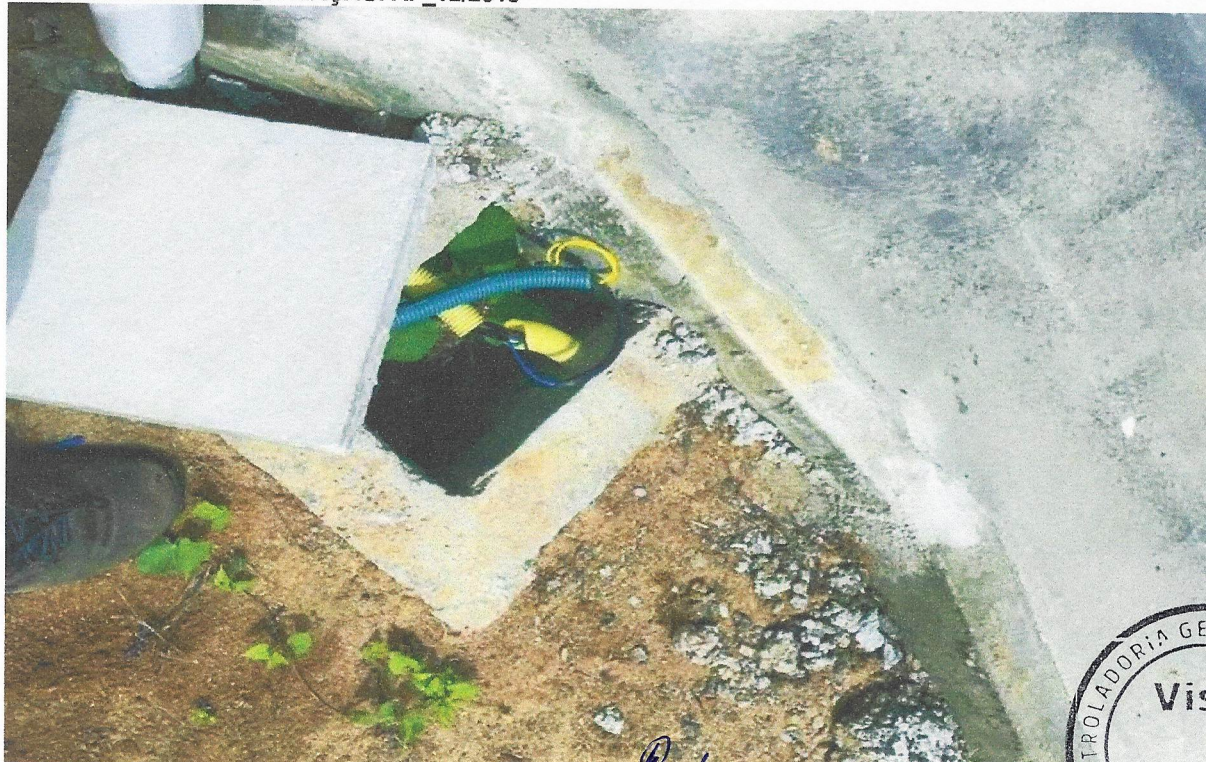
FOTO 14 - CABO DE COBRE FLEXÍVEL ISOLADO, 10 MM 2 , ANTI-CHAMA 450/750 V, PARA DISTRIBUIÇÃO - FORNECIMENTO E INSTALAÇÃO. AF_12/2015
