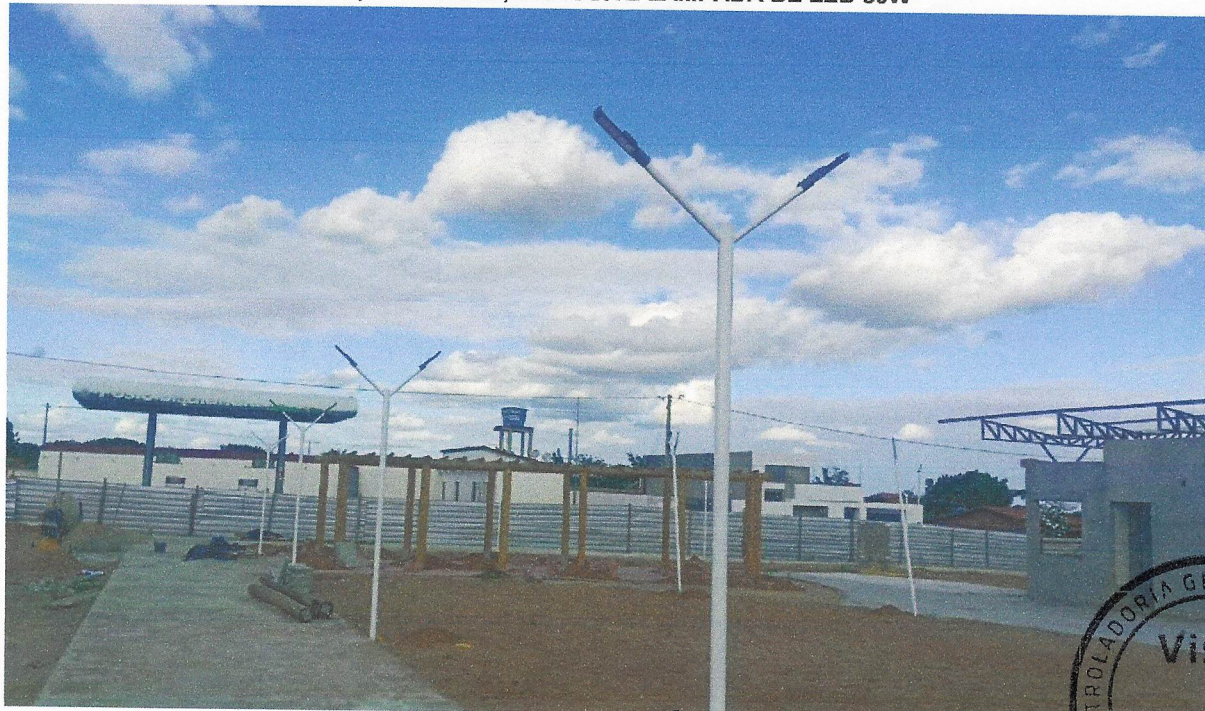
FOTO 06 - POSTE DECORATIVO 2 BRAÇOS, EM AÇO GALVANIZADO COM DIFUSOR EM VIDRO TRANSPARENTE TEMPERADO, COM 3M/4M, INCLUSIVE LÂMPADA DE LED 50W
