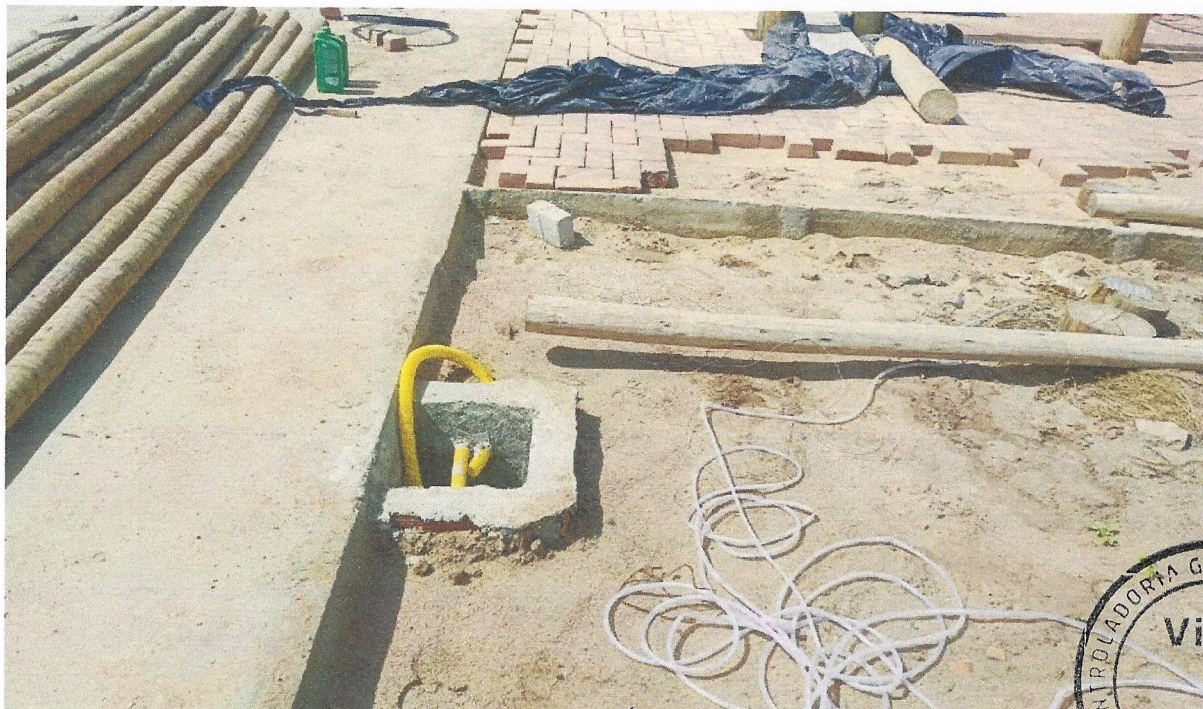
FOTO 04 - CAIXA DE PASSAGEM EM ALVENARIA DE TIJOLOS MACIÇOS ESP. = 0,12M, DIM. INT. = 0,30 X 0,30 X 0,30M
