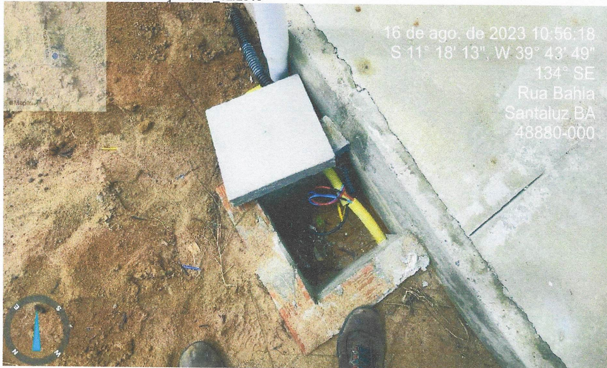
FOTO 14 - CABO DE COBRE FLEXÍVEL ISOLADO, 10 MM 2 , ANTI-CHAMA 450/750 V, PARA DISTRIBUIÇÃO - FORNECIMENTO E INSTALAÇÃO. AF_12/2015
