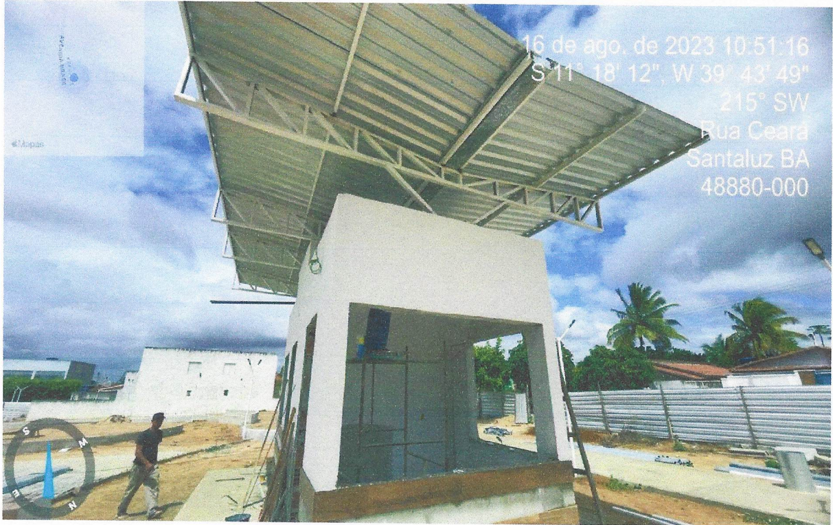
FOTO 24 - TELHAMENTO COM TELHA METÁLICA EM CHAPA DE AÇO GALVANIZADO NATURAL ONDULADA E=0,5MM
