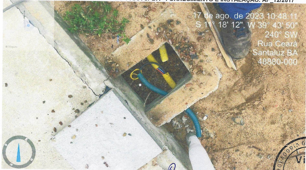
FOTO 12 - "HASTE DE ATERRAMENTO 5/8 PARA SPDA - FORNECIMENTO E INSTALAÇÃO. AF_12/2017"
