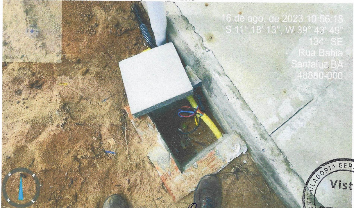
FOTO 16 - CABO DE COBRE FLEXÍVEL ISOLADO, 1,5 MM 2 , ANTI-CHAMA 450/750 V, PARA CIRCUITOS TERMINAIS - FORNECIMENTO E INSTALAÇÃO. AF_12/2015
