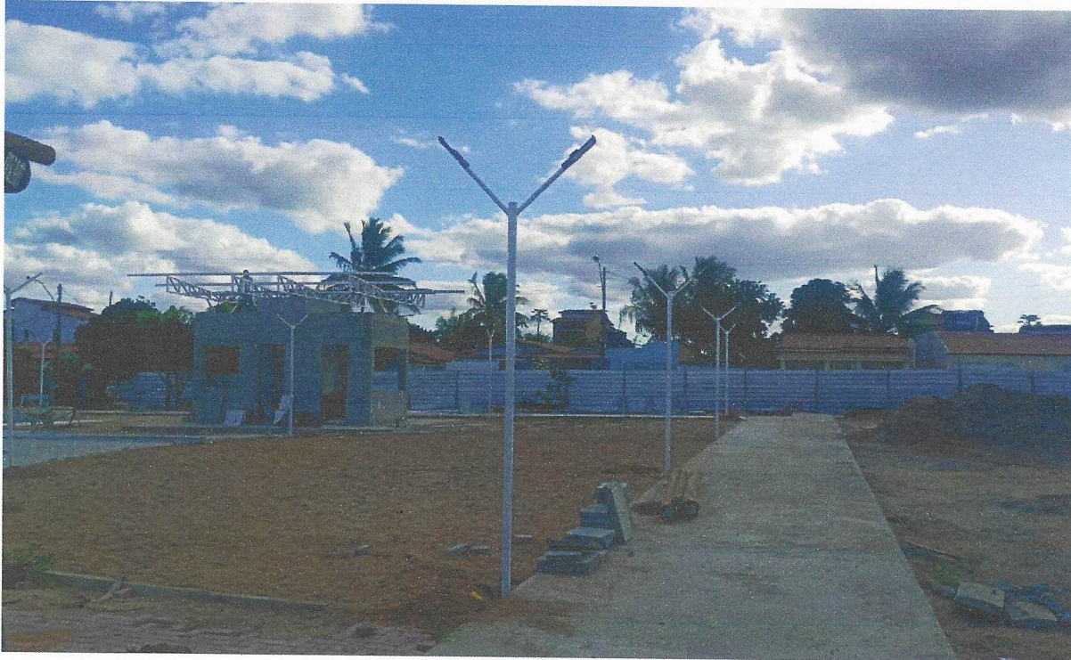
FOTO 06 - POSTE DECORATIVO 2 BRAÇOS, EM AÇO GALVANIZADO COM DIFUSOR EM VIDRO TRANSPARENTE TEMPERADO, COM 3M/4M, INCLUSIVE LÂMPADA DE LED 50W
