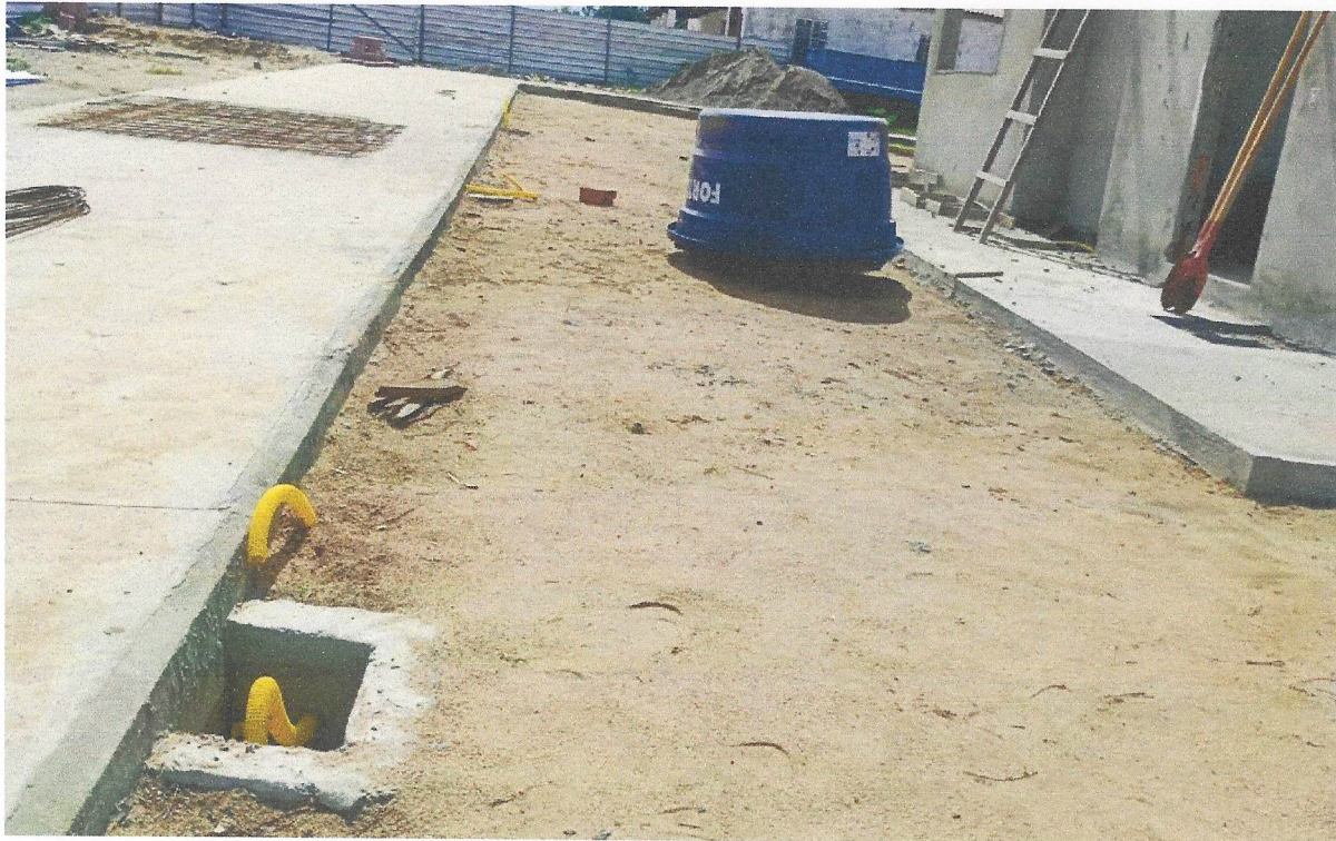
FOTO 04 - CAIXA DE PASSAGEM EM ALVENARIA DE TIJOLOS MACIÇOS ESP. = 0,12M, DIM. INT. = 0,30 X 0,30 X 0,30M
