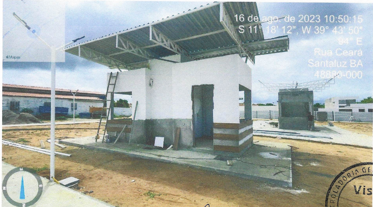
FOTO 24 - TELHAMENTO COM TELHA METÁLICA EM CHAPA DE AÇO GALVANIZADO NATURAL ONDULADA E=0,5MM
