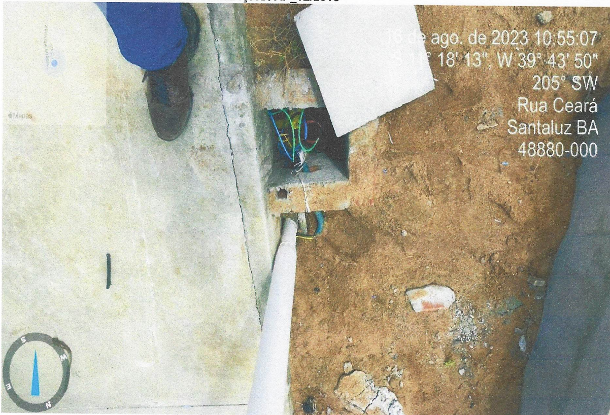
FOTO 18 - CABO DE COBRE FLEXÍVEL ISOLADO, 2,5 MM 2 , ANTI-CHAMA 450/750 V, PARA CIRCUITOS TERMINAIS - FORNECIMENTO E INSTALAÇÃO. AF_12/2015
